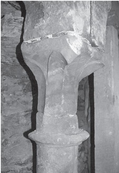
Abb. 5: Nikolaikirche, Südturm, Zungenblattkapitell an der Schallarkade mit Brandschäden, Sandstein aus dem Raum Niederschöna-Tharandt, Aufnahme 1993
