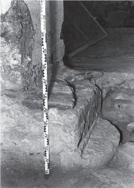
Abb. 30: Freiberg, Nikolaikirche, halbrunde Vorlage eines spätgotischen Innenpfeilers, die im Barock abgearbeitet wurde, Aufnahme 1994
